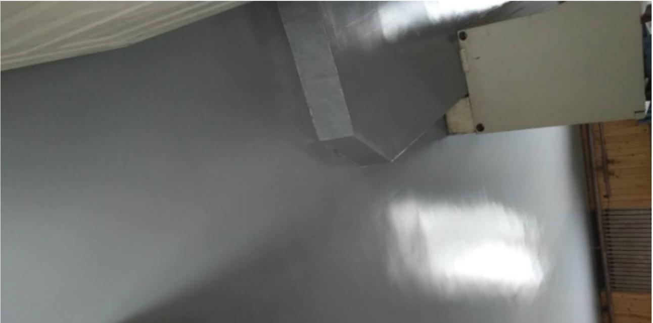
聚脲涂料施工时要保证在正常的温度范围以内，超过零下温度时切记不可施工，这样会使涂料的效果大打折扣，严重的威胁防水性能。除此之外当温度过高时（如夏季暑伏等极端温度情况下）也不宜施工，温度过高也会使涂料的有效成分受损，由于各喷涂速凝涂料的整体原料成分不同，所以具体的施工温度需根据实际情况确定。一般情况下聚脲涂料施工需要在无大风大雪条件下进行施工，超过四级以上风力时不宜施工，如果地面返潮严重时也会对施工有一定障碍。但是一些品牌的聚脲?涂料等级较高产品功能性极强，地面潮湿时也可施工，但无论何种喷涂速凝涂料施工，都必须保证地面上无明水，否则会影响粘接力。当聚脲涂料施工完毕后需要数个小时进行表层干固，一般干固时间需持续几个小时左右，如果现场温度过低或者湿度过大、通风性较差的环境下，会相应的延长干固时间，反之会使干固时间缩短。一般来说聚脲涂料施工实干后才可以进行触摸，在短时间内频繁接触会影响防水效果。山东德士力新材料，提供周到的解决方案，满足客户不同的服务需要。山西天桥聚脲生产
