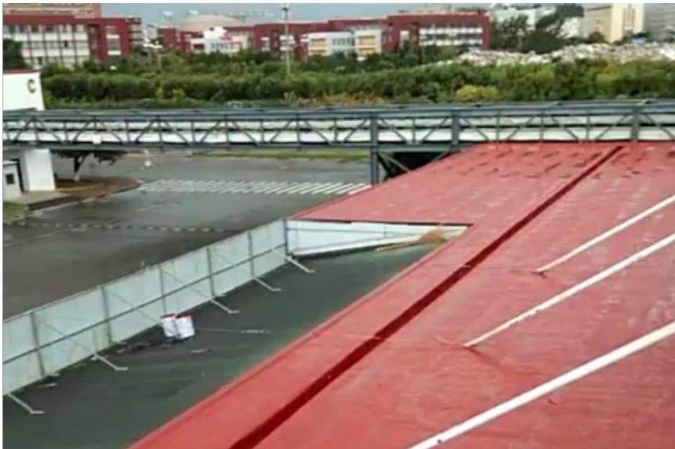
1) 聚脲防水涂层是一种弹性防水材料、具有好的防水性、防滑和行走舒适性；2) 防水、防腐、装饰一体化设计。涂层耐老化优，涂层饱满、装饰美观，经久不变色；3) 附着力好，长期使用不起泡，不脱落，不空鼓；4) 安全系数高，具有高的防湿滑性能；5) 力学性能优，高的拉伸强度，保涂层抵混凝土开裂；6) 低温柔韧性能优，-40℃——60℃环境下长期使用不开裂脱落；7) 防腐性能好，可耐受水、酸、碱、盐、油等介质的侵蚀；8) 施工简便性，喷涂施工速度快，可一次性完成设计的涂膜厚度，单机日工作量可达1000m<sup>2</sup>以上。聚脲涂料池体系设计用于混凝土基面应用，以聚脲涂料为主材，全部材料为环保材质的\*\*成熟系统。经过了欧洲的BBA认证，并且有通过WRAS饮用水认证的系统。天津聚氨酯防水材料山东德士力新材料科技有限公司，塑造健康
